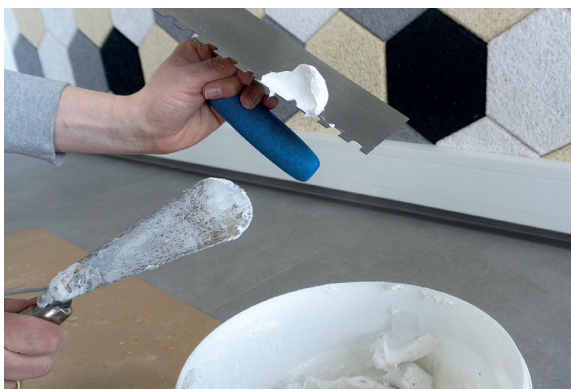
1: Nałóż niewielką ilość kleju montażowego FibroTech na szpachelkę lub podobne narzędzie.
