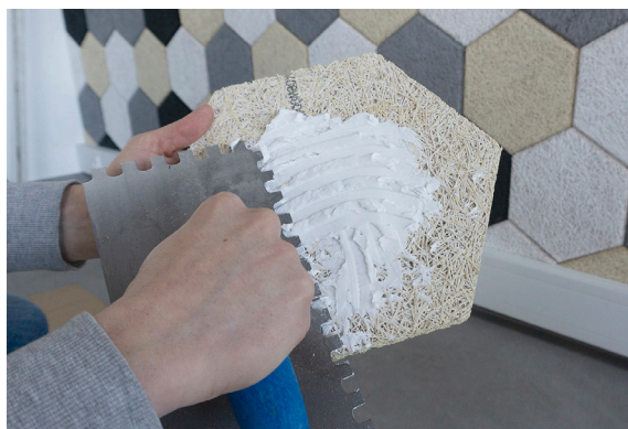
2: Rozprowadź za pomocą szpachli lub podobnego narzędzia klej montażowy FibroTech na pojedynczym sześciokącie.
