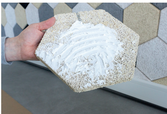
3: Kontynuuj rozprowadzanie dobrej warstwy kleju montażowego.
