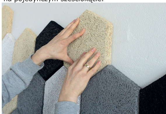
4: Następnie ustaw pojedynczo sześciokąt we wzorze, który chcesz utworzyć. Pamiętaj, że możesz łatwo wyciąć sześciokąty, aby uzyskać dokładnie taki wzór, jaki chcesz uzyskać. Kontynuuj proces, aż uzyskany wygląd będzie kompletny.
